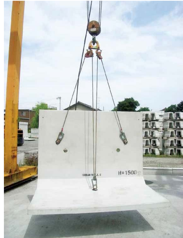
施工吊り上げ
