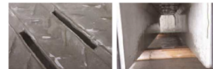
スリット孔からの排水状況
